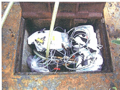
写真 3.5.7 計測機器設置状況（消火栓）
