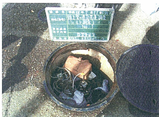
写真 3.5.3 計測箇所 No. ① φ250 鋼管 (SP) 空気弁
