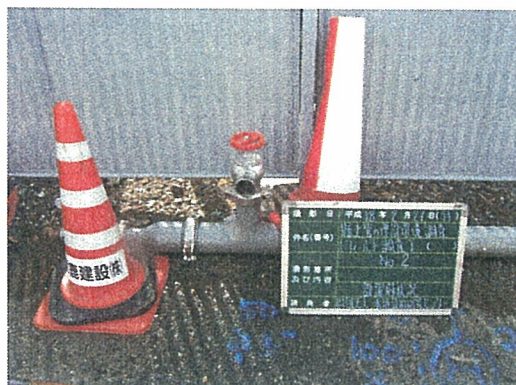
写真 3.5.4 計測箇所 No. ② φ100 塩ビ管 (VP) 仮設消火栓
