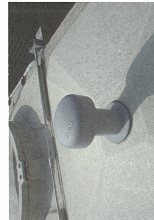
7-8改善後 正常な状態
