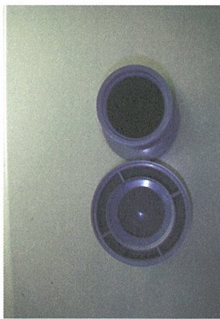
7-22改善後 正常なもの
