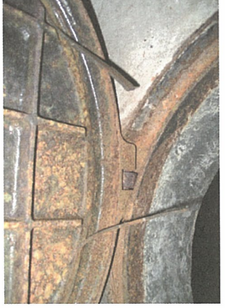
5-11改善前 マンホールの腐食と密閉用のパッキン無
