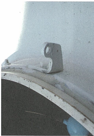
5-13改善後 施錠部品の取付け
