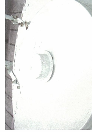
7-10改善前 マンホール部の通気口(埃等が入り易い)
