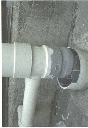
6-15改善後 排水受けを切り空間を設ける
