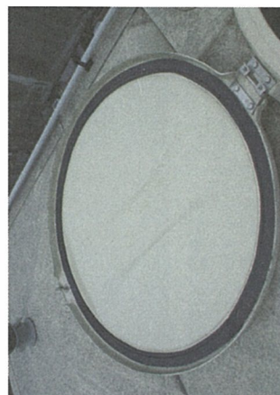
5-24改善後 ハッキンの取付け
