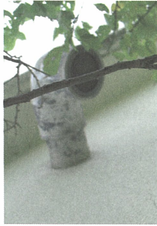
7-4改善後 管端部に下り幅を設ける
