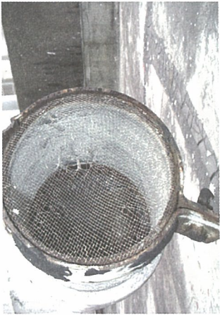
6-11改善後 管端部を防虫網で覆う
