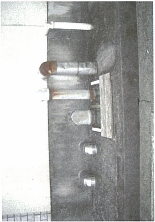
6-3改善後 管端部に下り幅を設ける
