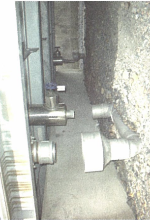
8-6改善後 管端部を切断し排水受けと切り離し
