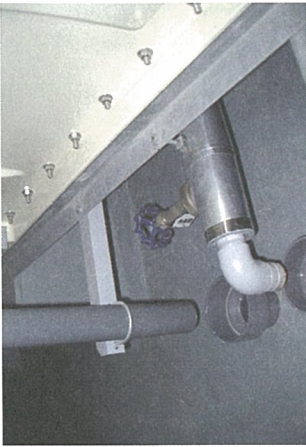
6-13改善後 排水口空間がある状態
