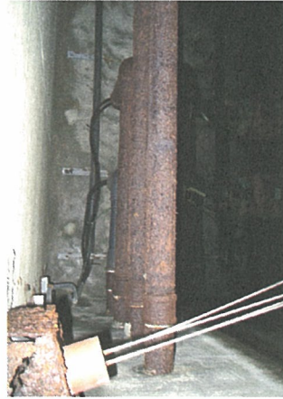
4-19改善前 水槽内部の給水管以外の配管設備
