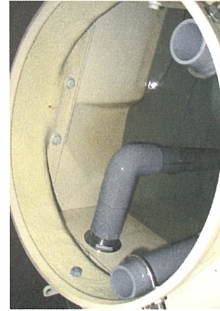
4-21改善前 流入管の吐出口空間なし
