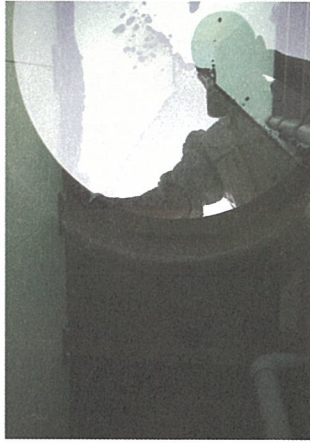
4-2改善前 水槽内部の汚れ、沈積物
