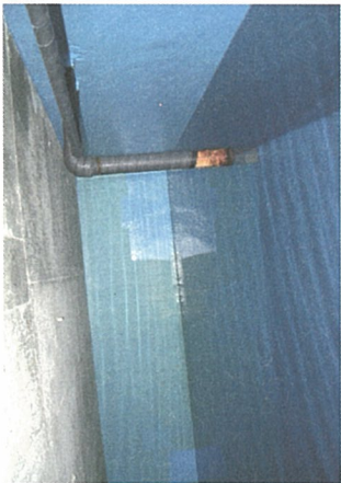
4-15改善後 腐食部補修後の樹脂コーティング
