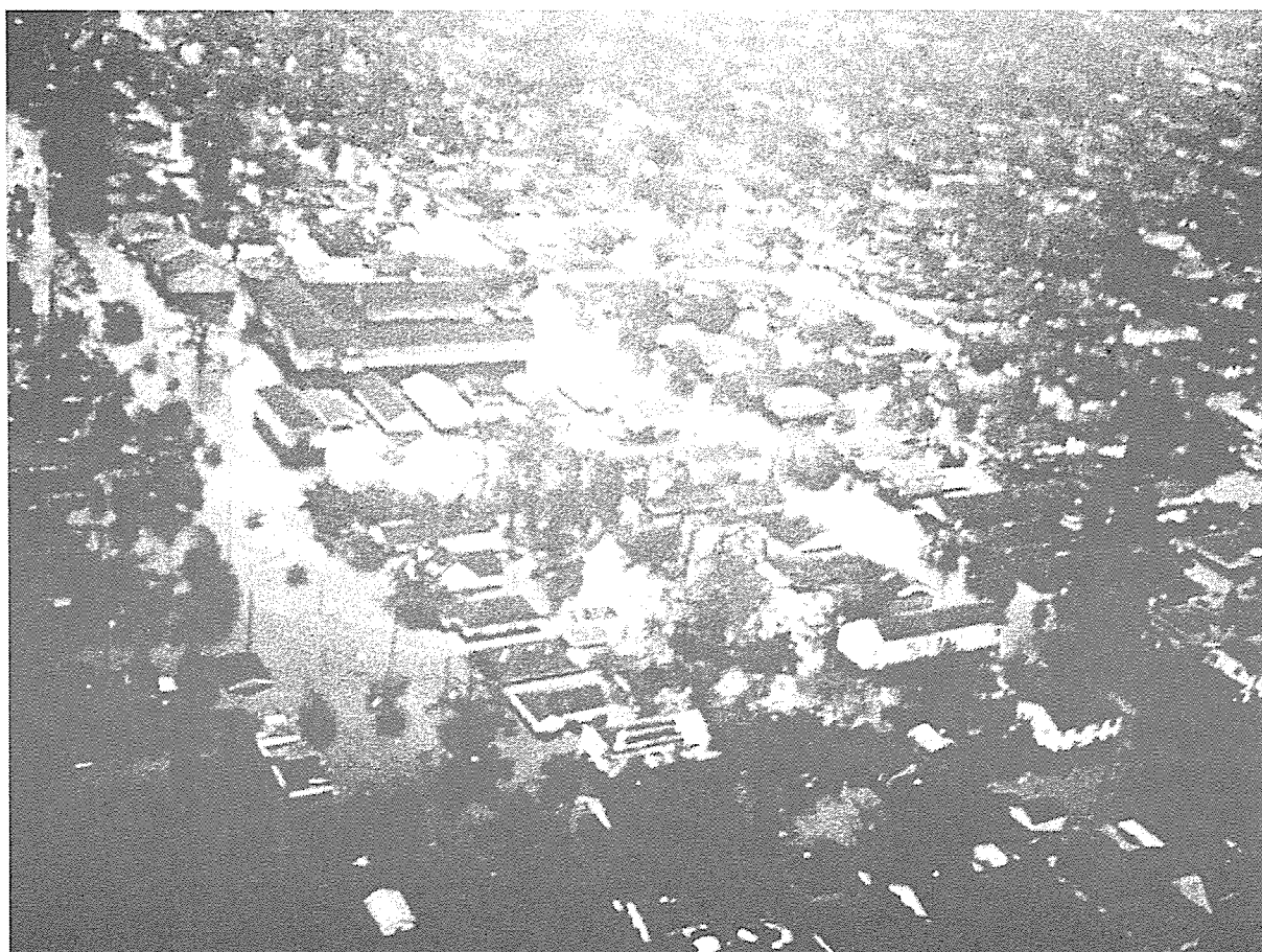
図1 ハリケーン・カトリーナによる市街の水没状況
