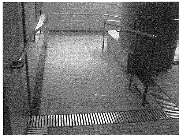
写真 1.3.7 施設 I のスロープ
