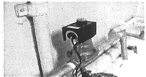
写真 2-1 電磁弁
