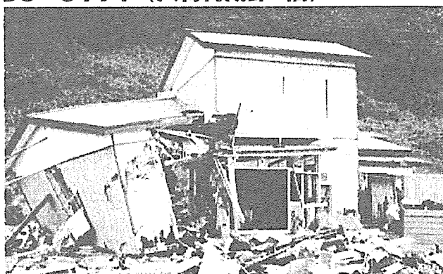
大津波による被害例 (1993年 日本海中部地震)
