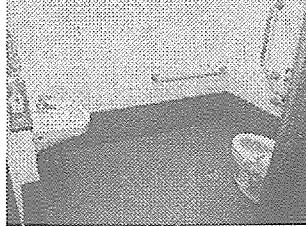
写真4 車いす用便所に改修
