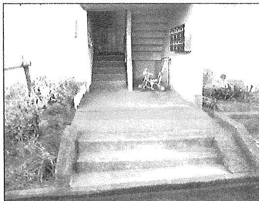
出入口の段差
