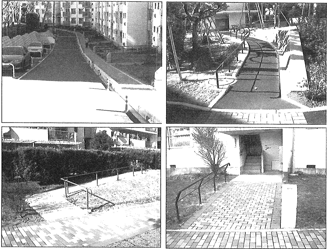
図-19：改修工事終了後のエリア（百草団地）
