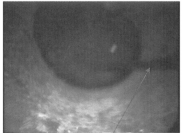
写真 7.2.50 防錆装置設置状況 (管内)
