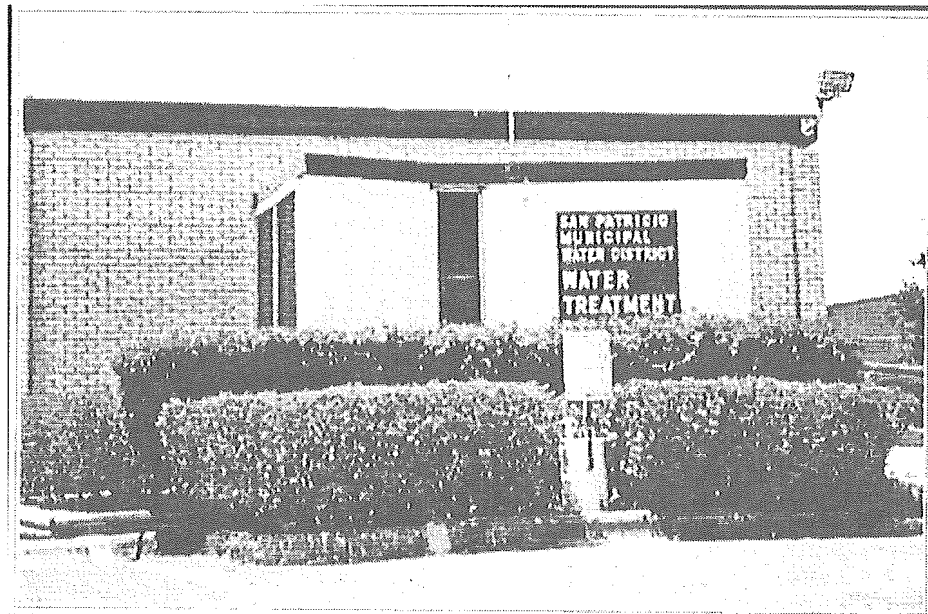
写真 6 - 3 3 サンパトリシオ浄水場
