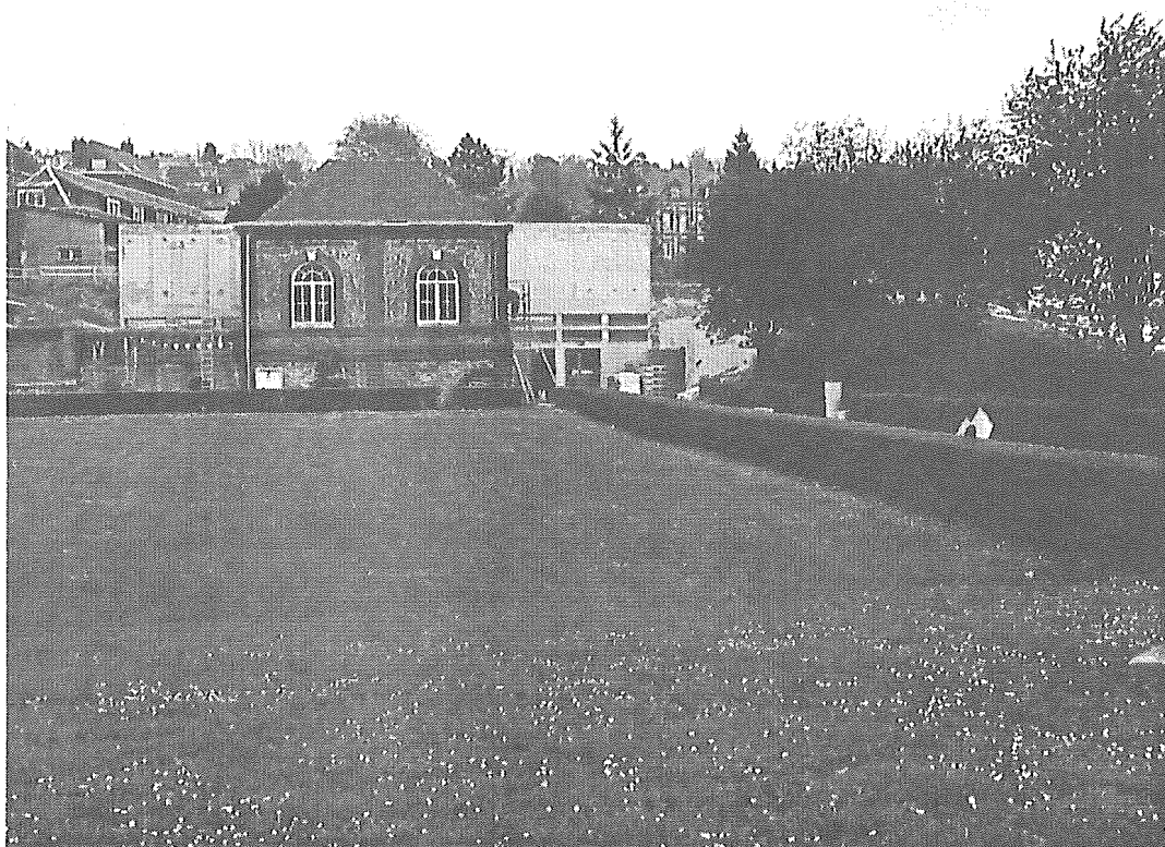
写真6-39 ルアン浄水場全景
