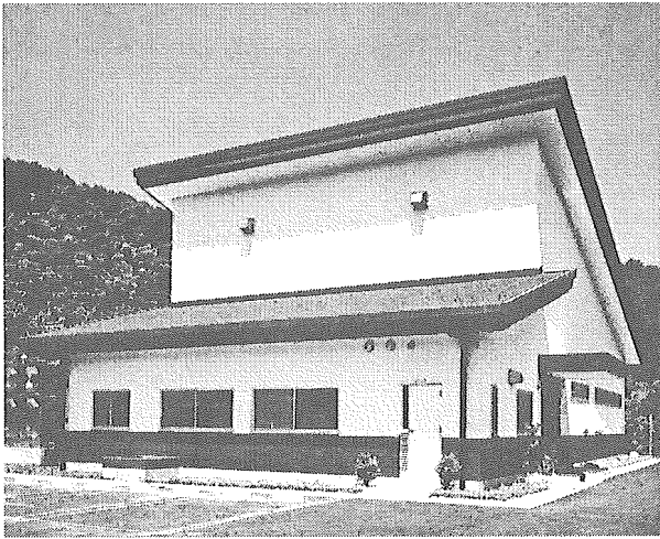
写真6-7 越生町膜ろ過施設全景
