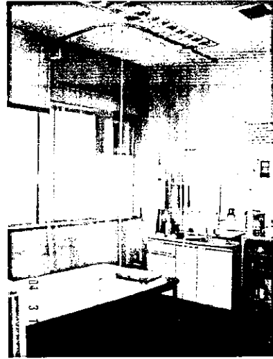
対策後：防炎スクリーンで囲いこみ換気扇を設置
