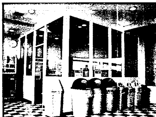
対策後：喫煙室に排気装置4台
