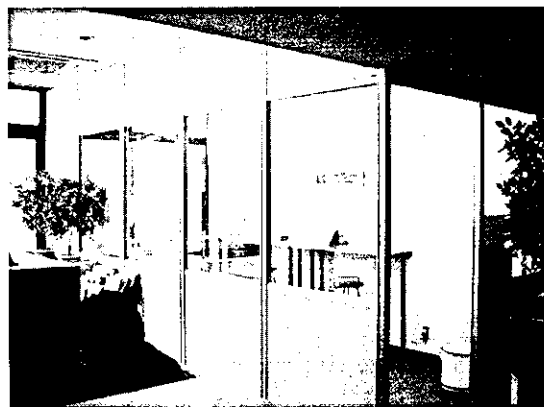
パネルで喫煙室を作成、換気扇2台
