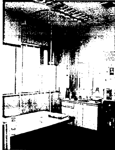
対策後：防災スクリーンで囲いこみ換気扇を設置
