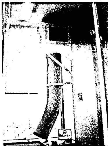
押し出し式の窓の隙間から換気扇と排気ダクトを用いて排気
