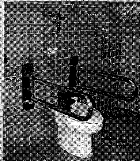
障害者用トイレ
