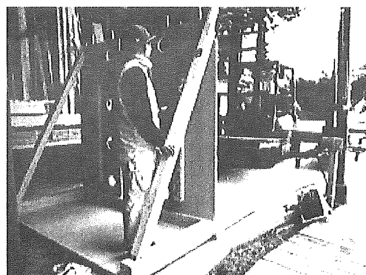
⑩斜め材 8、9 を床材 2 の両端の穴に差し込んで
