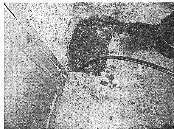
図 4.15 更新用 PE 管の引込み状況
