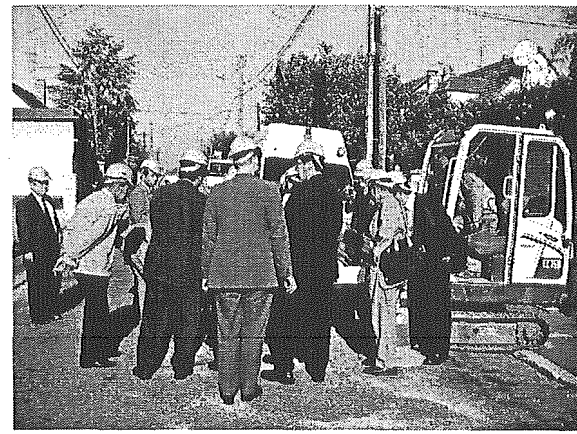
図 4.7 工事概要の説明状況
