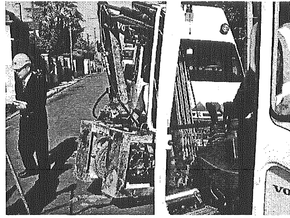
図 4.19 鉛管が巻きついたままのウインチ を移動させている状況
