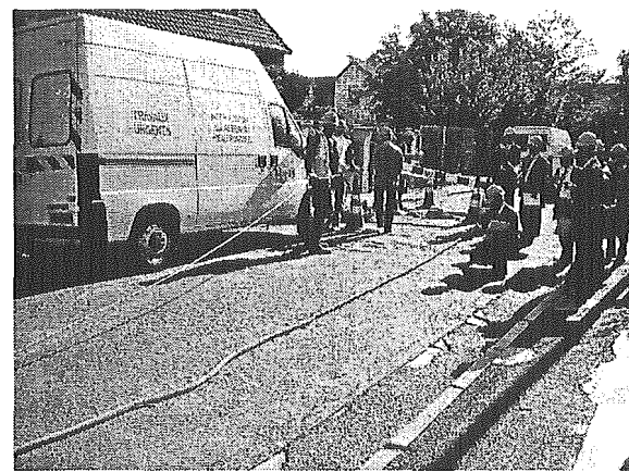
図 4.21 引抜かれた既設鉛管
