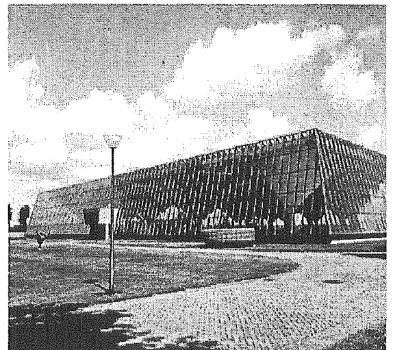
図 2.6 BerenPlaat 浄水場 ろ過機建屋
