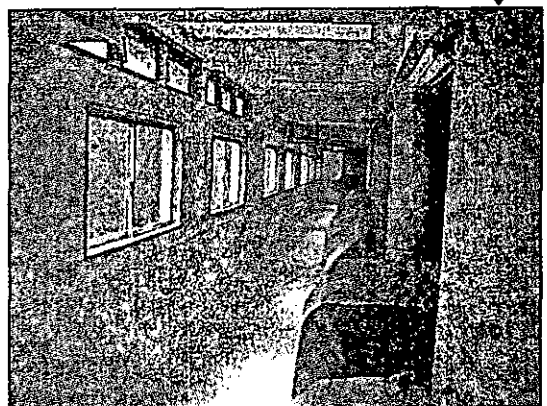
写真8: 窓のあいた空間(工事中)
