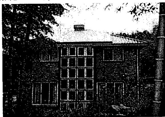
写真 12-1 煉瓦住宅概観
