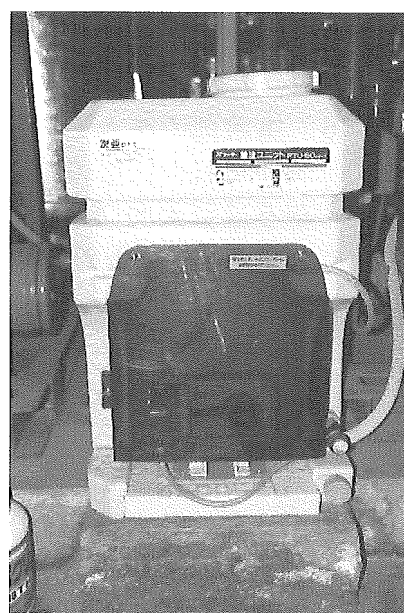
写真1 薬液注入装置
