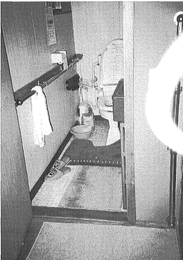
【資料3. 住宅改修されたトイレ】
