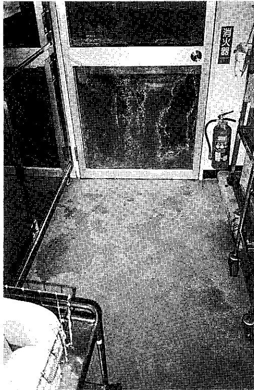
写真-3 T小学校 (ウェットシステム)
