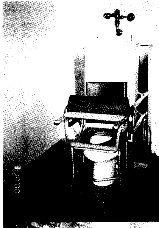
図6 工房トイレ2 木製よりステンレス製フレームを使用。全体の重さを軽くし、取り外しを容易にし、清潔に保つよう改善
