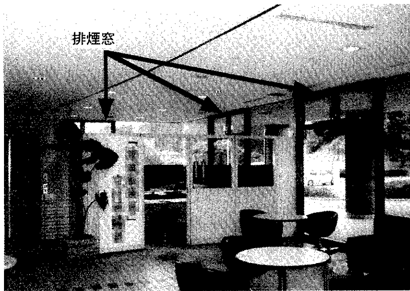
写真3. 喫煙コーナー新設事例
