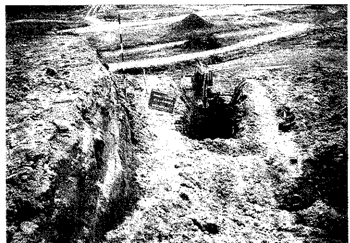
写真-4 法面部掘削状況
