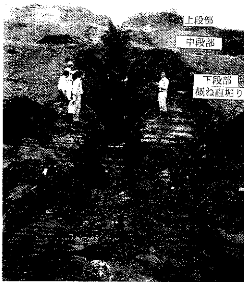
写真-7 掘削後全景
