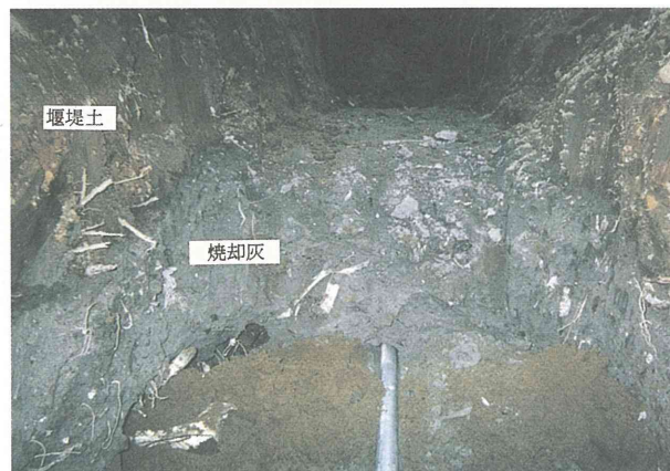
写真-17 採取用埋設管の設置状況 (最上段)
