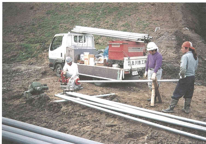
写真-13 採取用埋設管の作成作業状況
