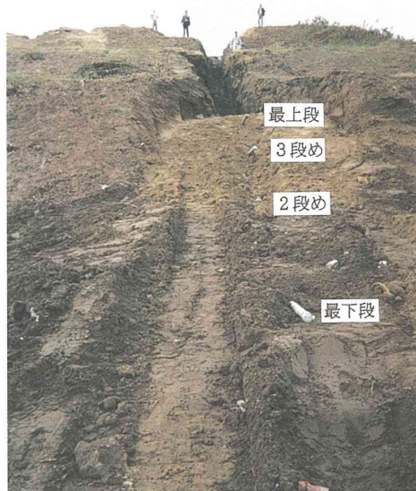
写真-14 採取用埋設管の埋設完了全景 (チューブ接続写真は別途)
