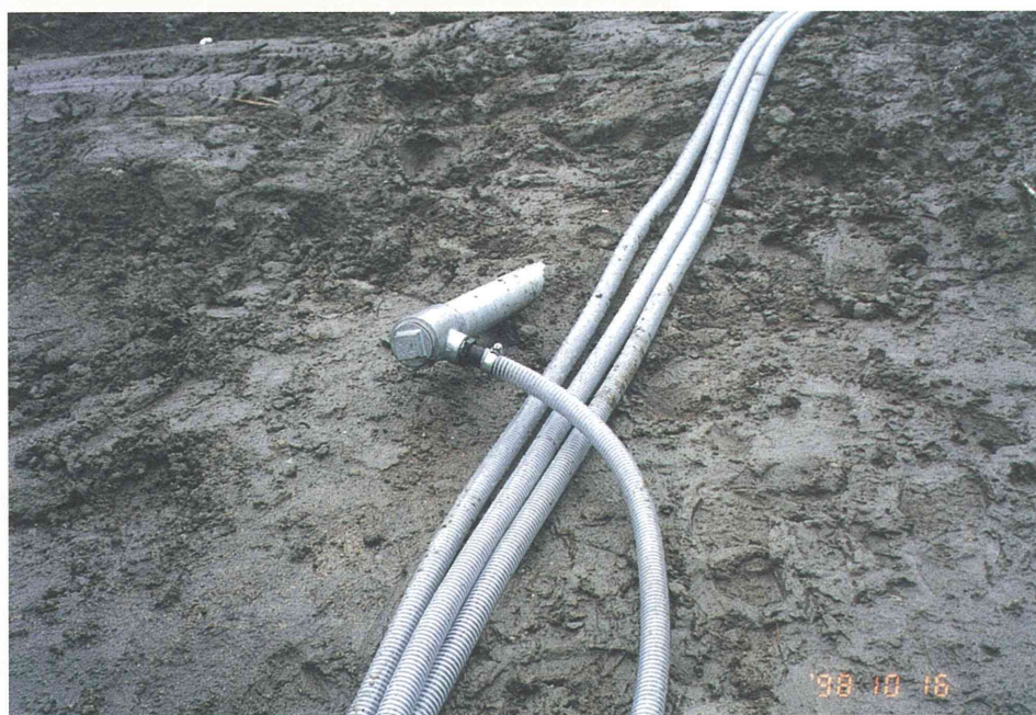
写真-22 浸出水サンプリング管と ホース
