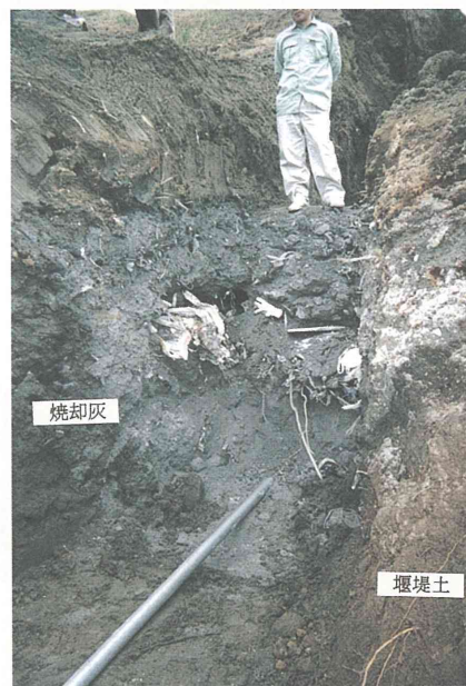
写真-16 採取用埋設管の設置状況 (3段め)
