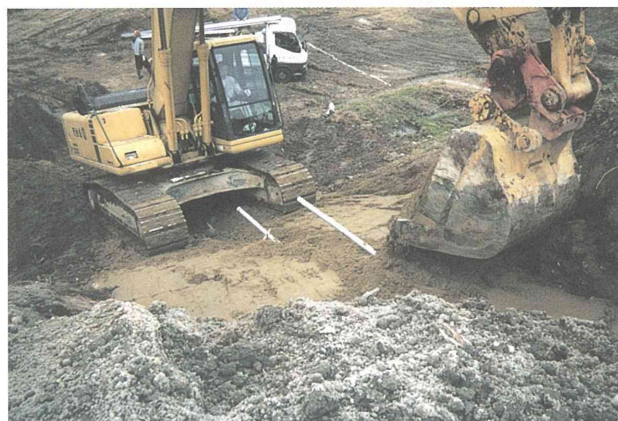
写真-18 埋め戻し状況
