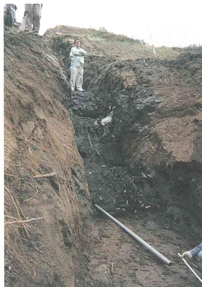
写真-15 採取用埋設管の設置状況 (2段め)
