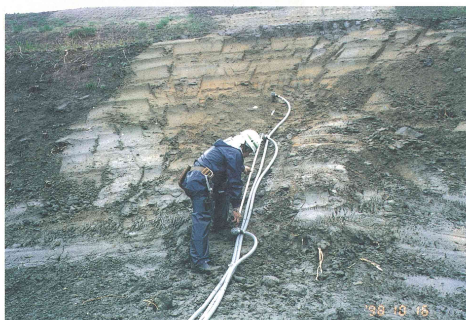
写真-23 浸出水サンプリング管と ホース
