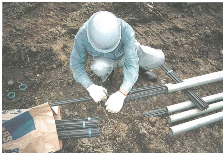
写真-12 採取用埋設管の作成作業状況 S字管 (50cm管内：50cm突き出し)
