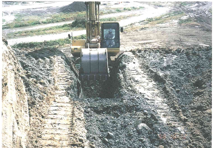
写真-3 最終覆土層から法面掘削状況
