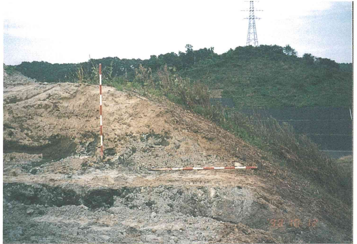
写真-2 最終覆土層（約1.3m）
