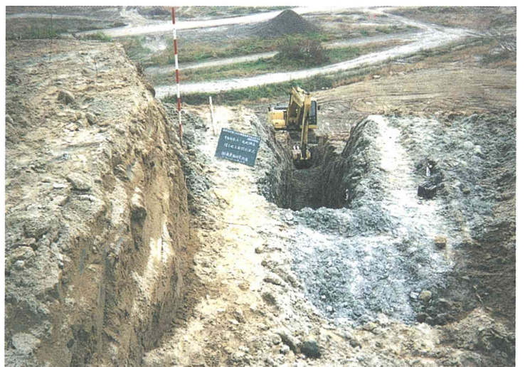
写真-4 法面部掘削状況
