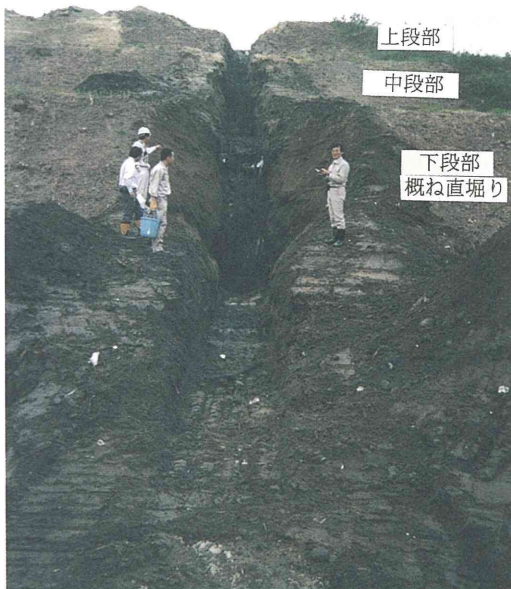
写真-7 掘削後全景
